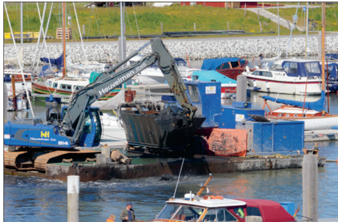
Die Baggerungen im Juister Bootshafen werden noch eine Weile dauern. FOTOS: STROMANN
