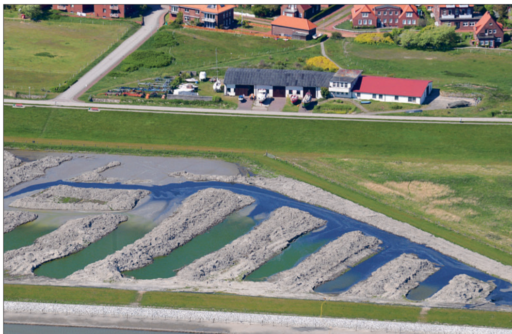
In dieses Spülfeld wird der Schlick, der aus dem Juister Bootshafen gebaggert wird, über eine Leitung gepumpt.
